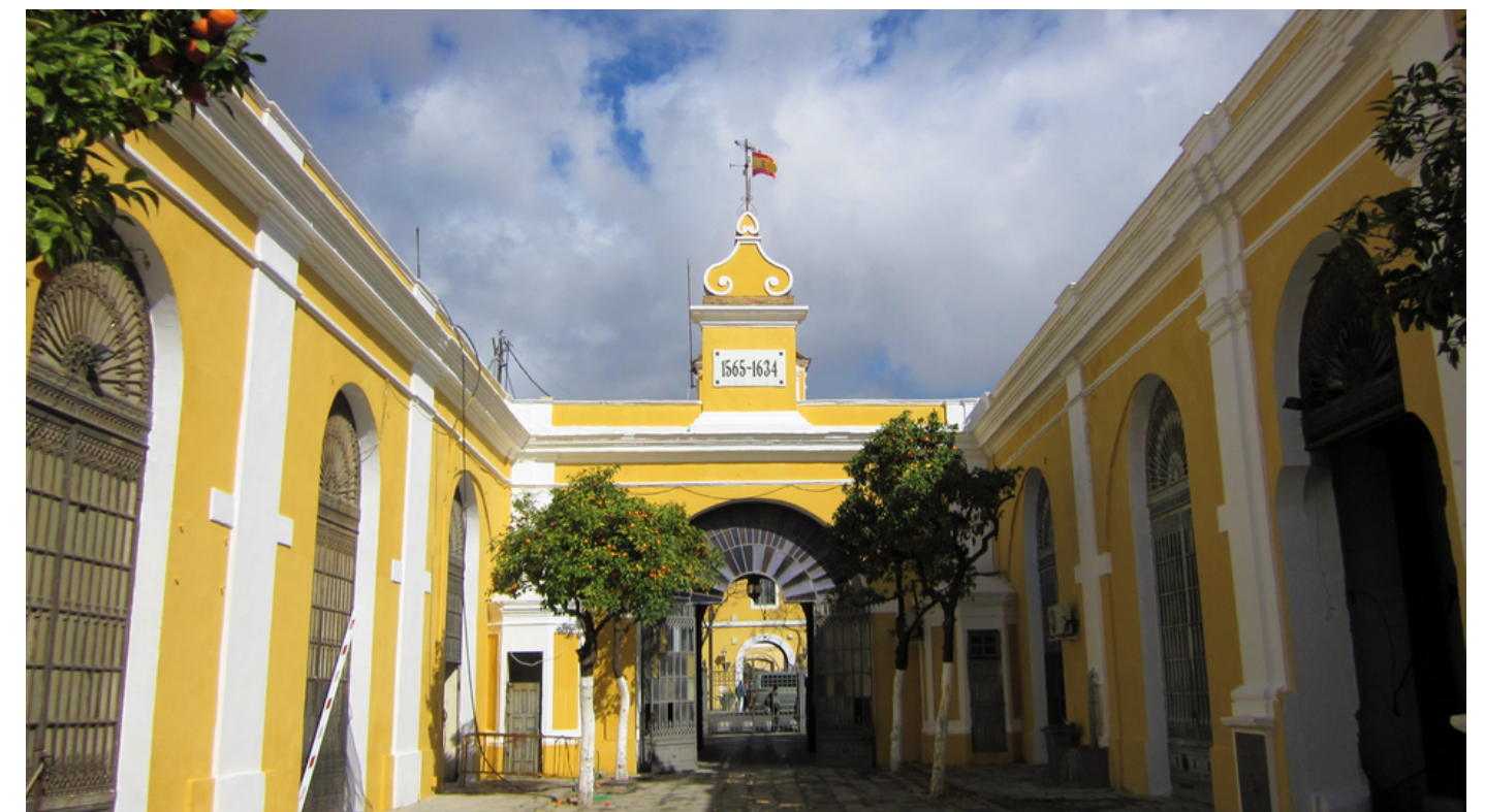
CONSULTORÍA PASSIVHAUS EN EDIFICIO HISTÓRICO: C&A
